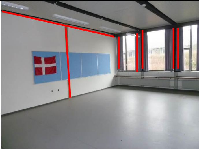
Klasseværelse med skillevæg med betonelementer tv. Fuger markeret med rødt: mellem søjler og vinduer, mellem betonvæg og dæk samt mellem vægelementer.
