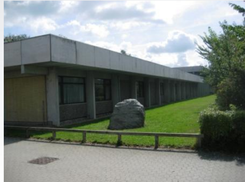
Frederiksberg Skole, vestfacade af blok 1.
